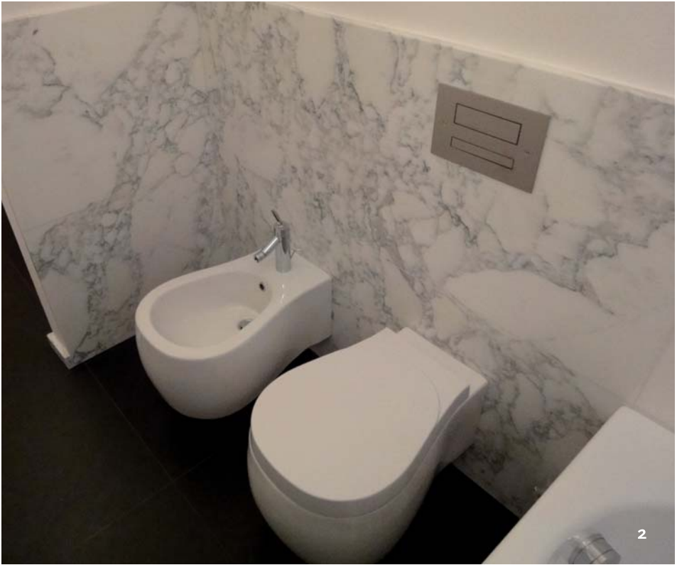
1. Piatto doccia e rivestimento a listelli in Travertino Navona. 2. Pavimento in granito Nero Assoluto e rivestimento in marmo Statuario Corchia. 3. Scala in granito Baja Dorato con finiture a toro.
